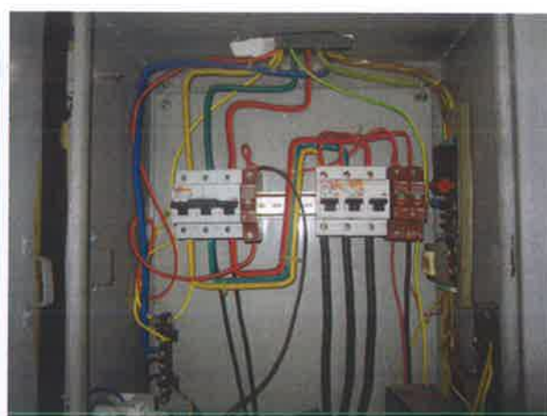
图 10：主开关无防误操作保护
