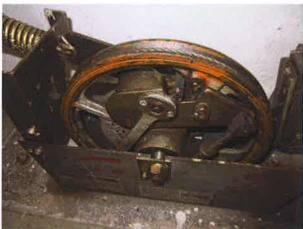
图 27: 限速器无防止异物进入的防护装置
