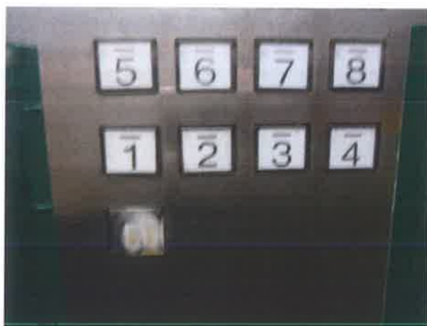
图 9：轿厢部分召唤按钮破损且动作不良
