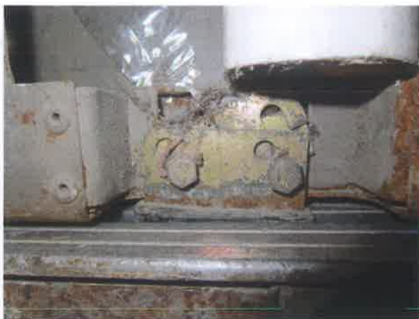
图 22：层门门滑块锈蚀磨损
