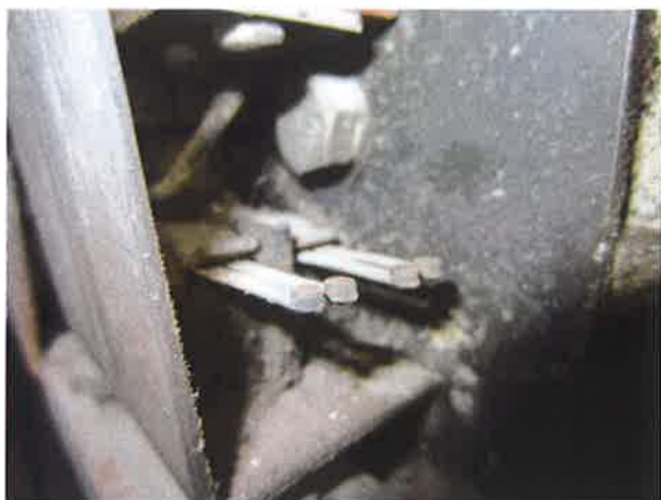
图 25: 层门门锁电气开关触点氧化
