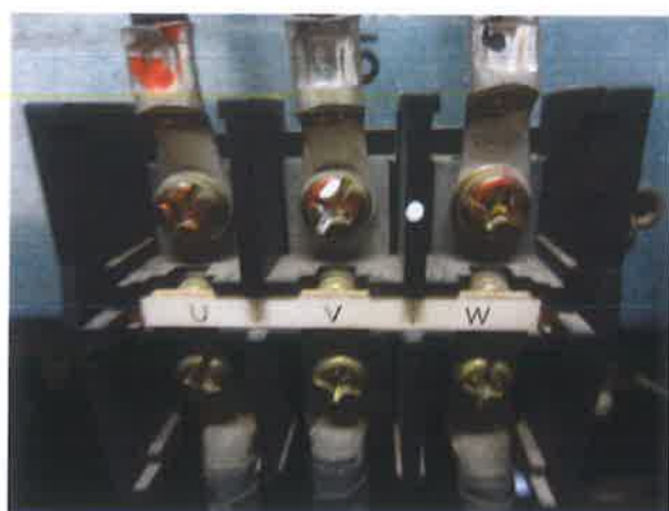
图 11：电气设备防护罩壳防护等级低于 IP2X
