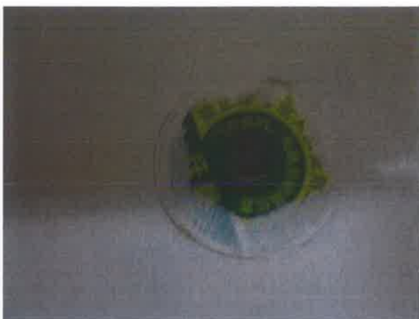
图 24：层门紧急开锁警示标识破损
