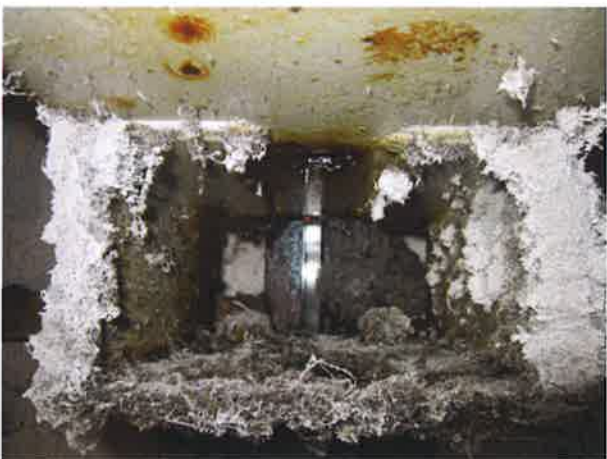
图 29: 安全钳有油泥异物
