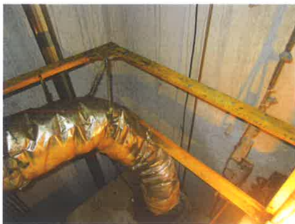
图 20：轿顶护栏设置不符合现行标准
