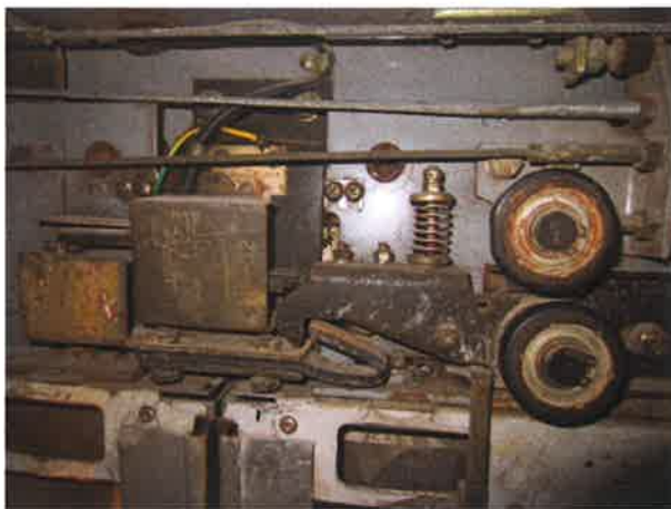
图 30: 无门锁短接保护功能
