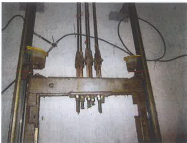
图 19：绳头组合无弹簧缓冲装置
