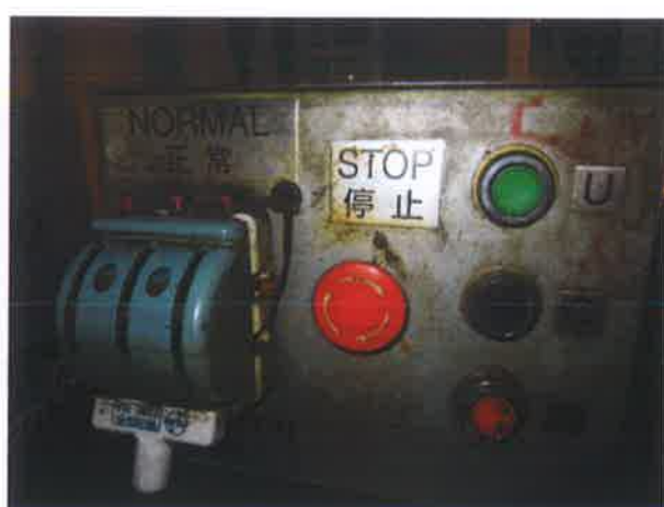
图 12：轿顶检修和急停开关无防误操作保护
