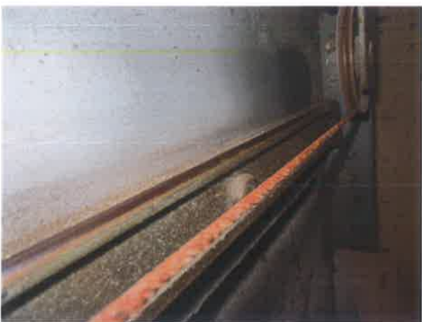
图 23：层门门头钢丝绳锈蚀
