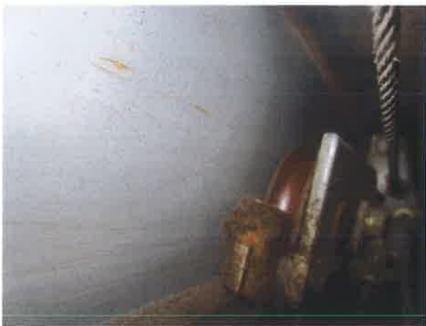
图 21：层门门挂轮胶圈老化
