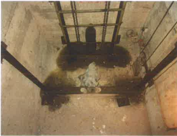
图 31：底坑对重运动区域防护不符合现行标准
